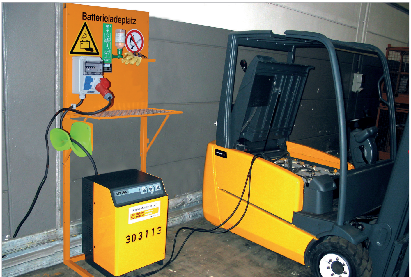
L met CEE krachtstroom-stopcontact 400 V, bij het opladen van een electro-heftruck
