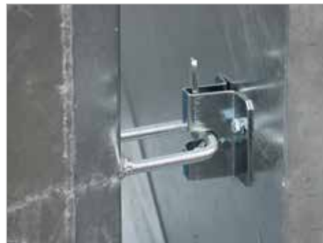
Automatische dekselvergrendeling
