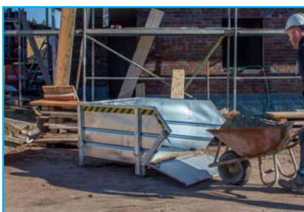
Bacs pour matériaux de chantier 32-33
