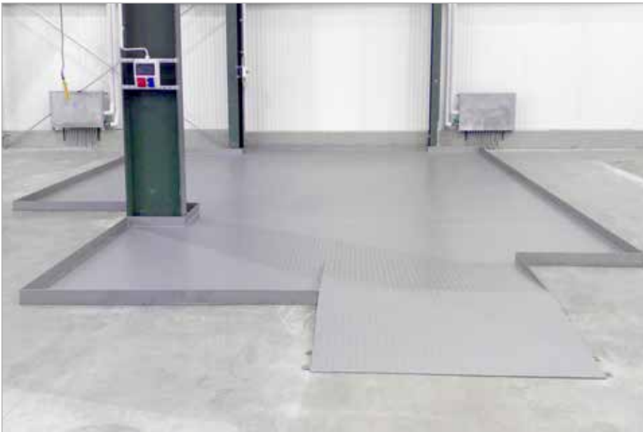
Bodembeschermbekledingen met uitsparing voor pijlers en overrijdplaten
