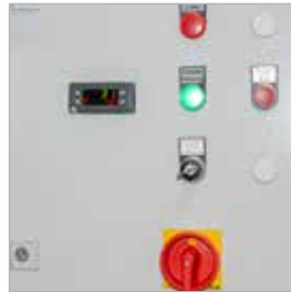
Schakelkast met digitale temperatuur-aanduiding
