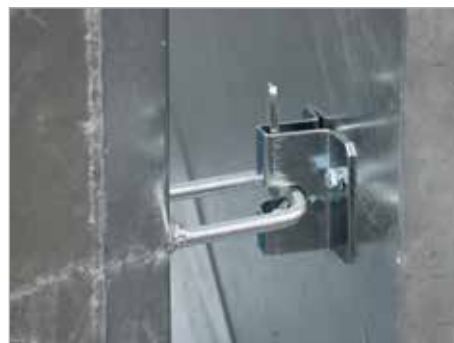
Automatische dekselvergrendeling
