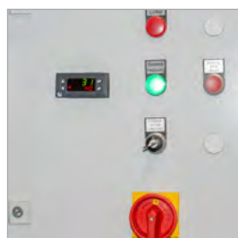
Schakelkast met digitale temperatuur-aanduiding
