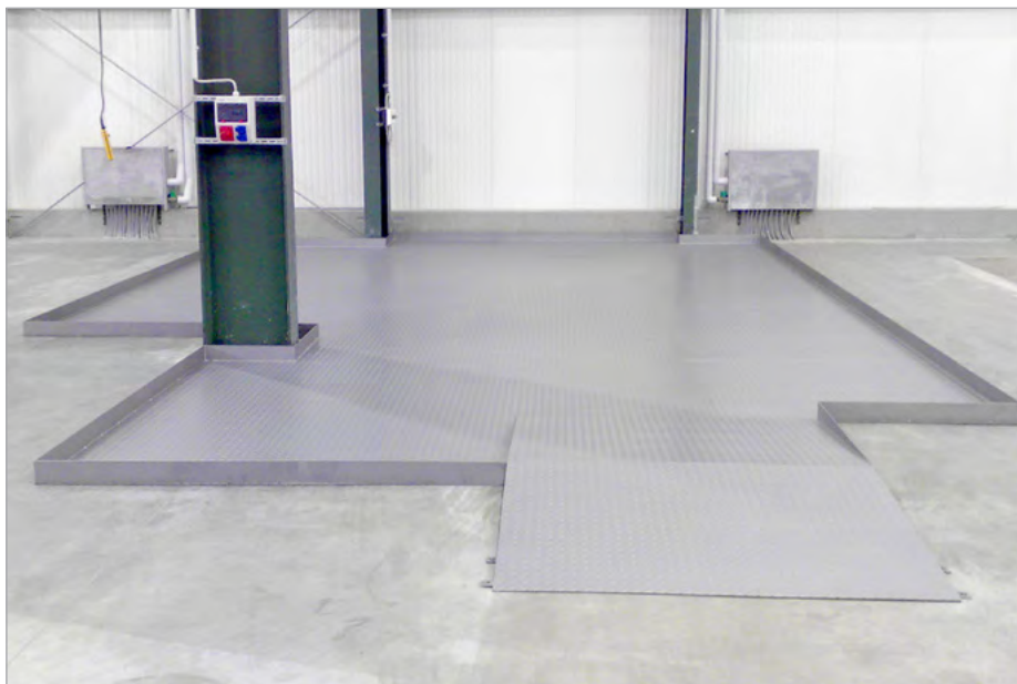
Bodembeschermbekledingen met uitsparing voor pijlers en overrijdplaten
