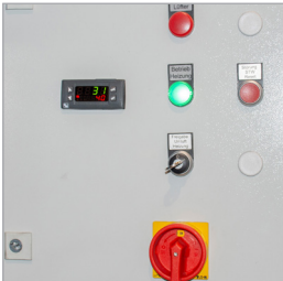
Schaltschrank mit digitaler Temperaturanzeige
